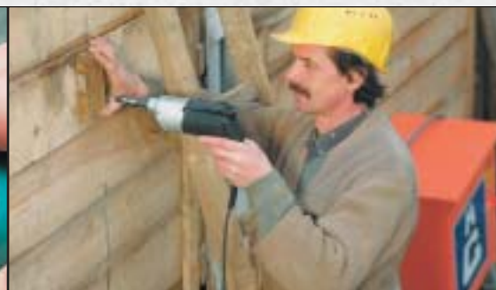
Постоянный магнит в битодержателе серьезно упрощает начало работы при заворачивании винта.
